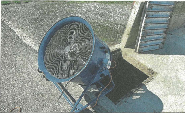
Für den Einstieg muss die Grube sehr gut gelüftet werden. Die Personen tragen Gasmessgeräte.
