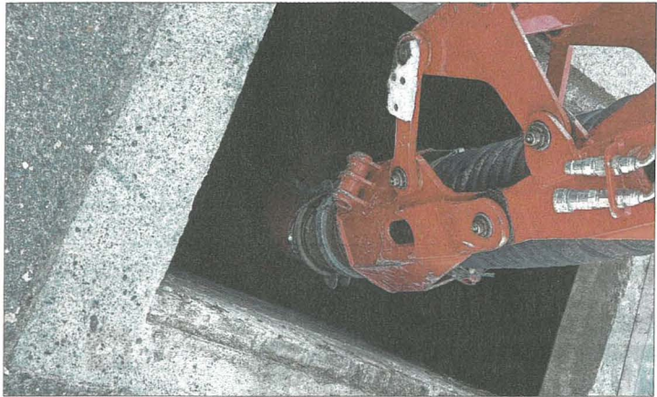
Mit dem Saugarm wird Material bis zu 25 cm Durchmesser aufgesogen. Er kann bis 150 Meter verlängert werden.
