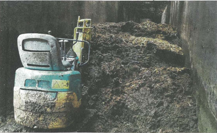
So werden massive Ablagerungen beseitigt: Mit dem Bagger in der Grube. Ein gutes Aufräumen spart Zeit und Geld.
