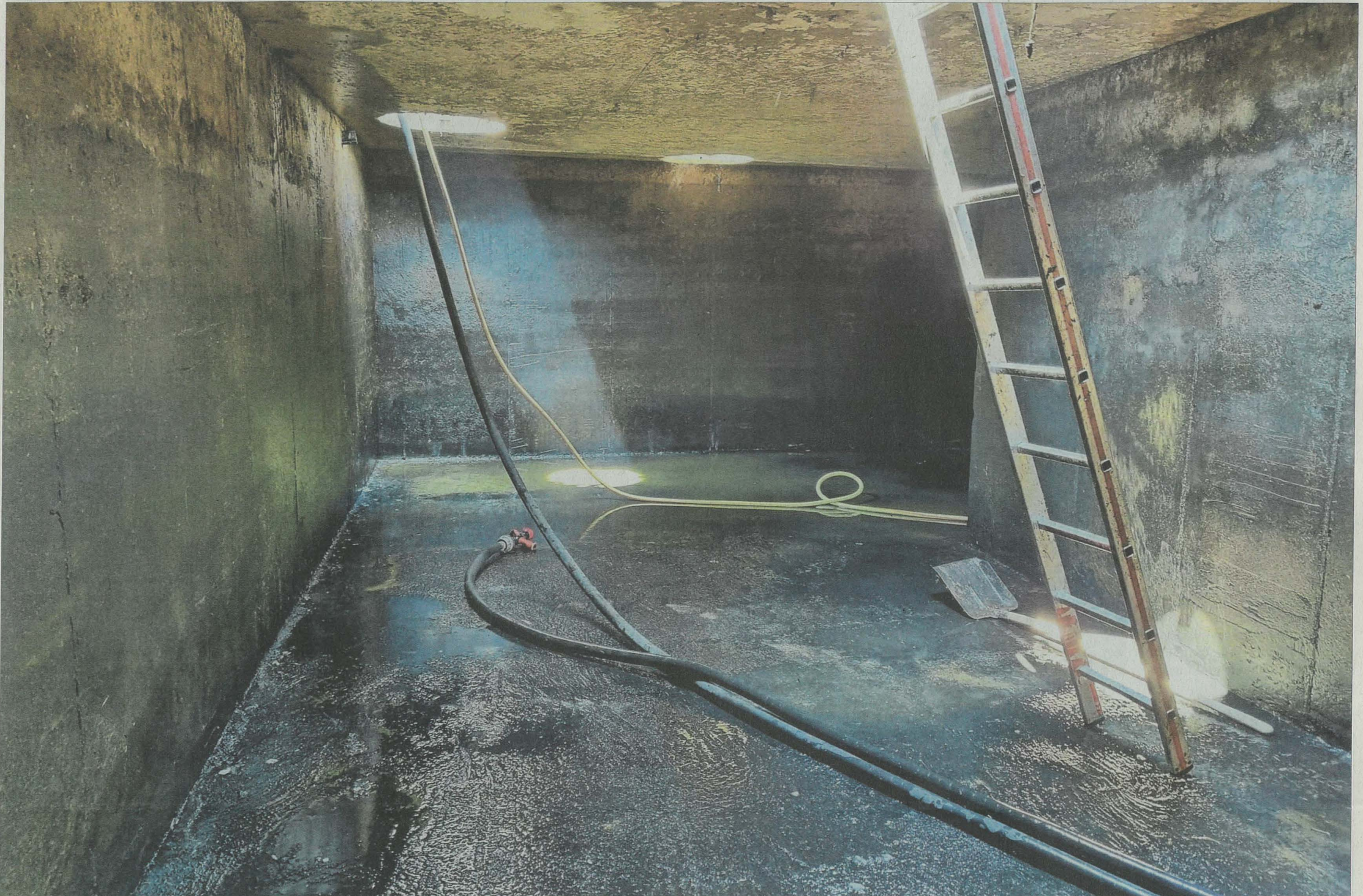
Das Gesetz sieht vor, dass bestehende Güllegruben periodisch kontrolliert werden müssen. Dies wird aber je nach Kanton unterschiedlich gehandhabt. (Bild: Ernefant)
